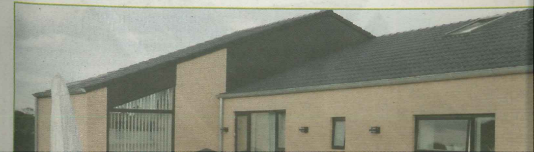
LAVENERGIHUS I FLAMINGO I Taulov ved Fredericia ligger der et hus, som er bygget af flamingoklodser og er et såkaldt lavenergihus, der næsten er selvforsynende med energi. FOTO: FLAMINGOHUSET
