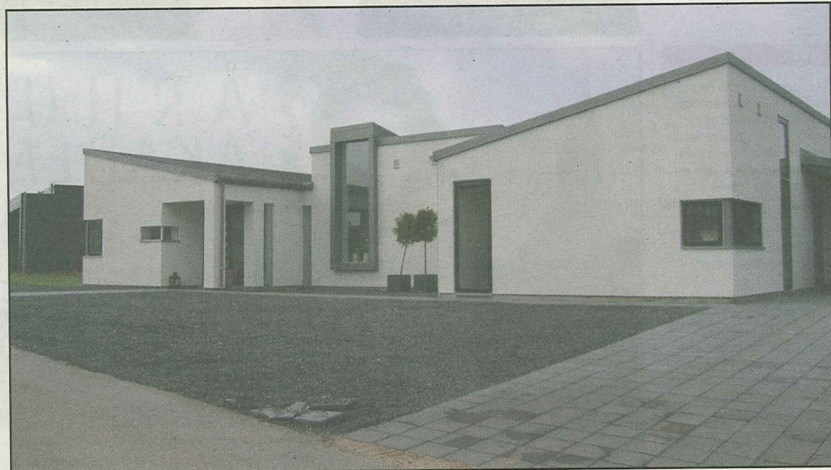
NÅR MAN HAR SAMLET magu-klodserne til et hus, hældes man flydende cement i deres hulrum. Det giver en konstruktion, som er stærkere end et hus lavet af mursten. Huset her hedder 'U-shape' og ligger i Randers.
